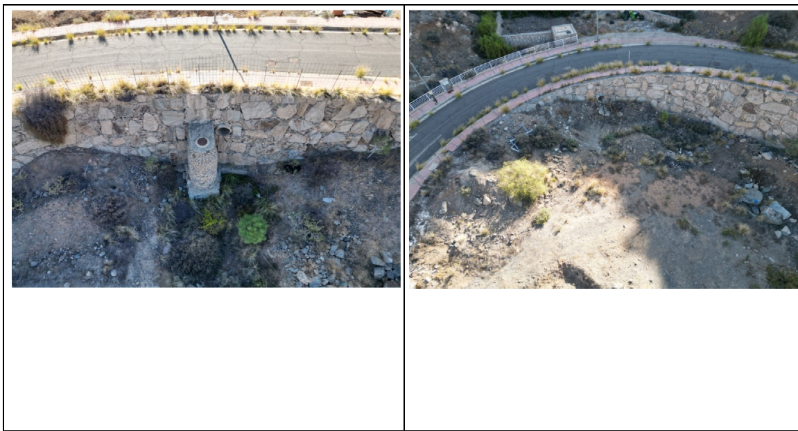
Fotografías infraestructuras hidráulicas existentes
